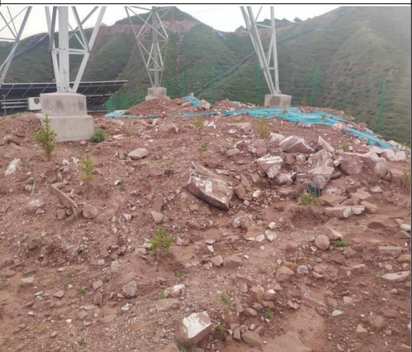
4#塔基土地回填及植被恢复
