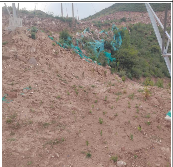
5#塔基土地回填及植被恢复
