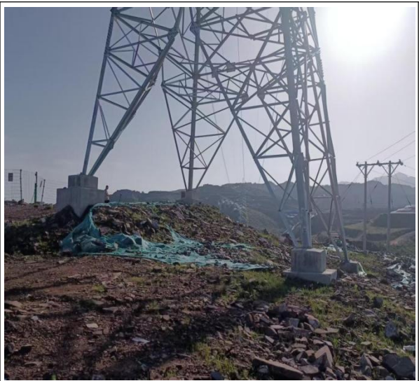
3#塔基土地回填及植被恢复
