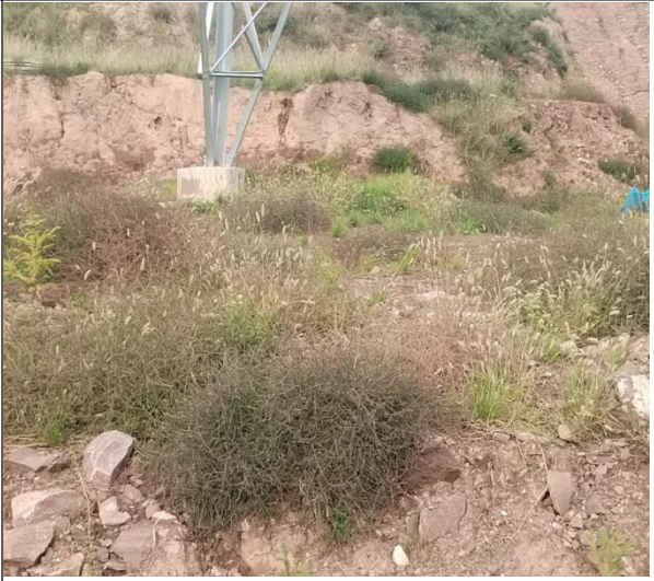
2#塔基土地回填及植被恢复
