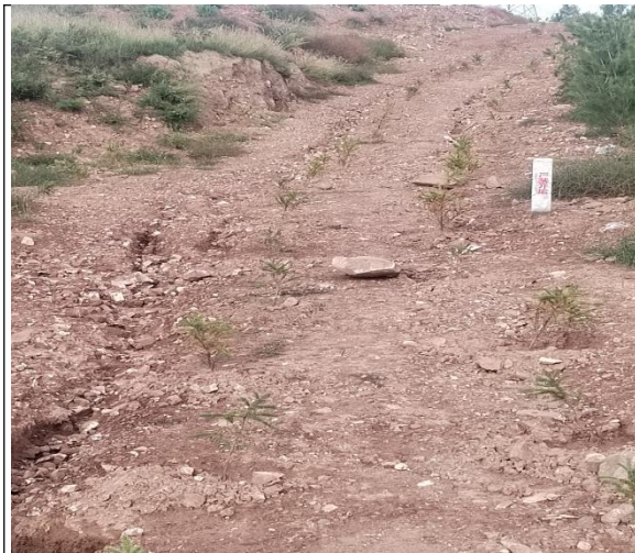
施工便道植被恢复（种植油松）
