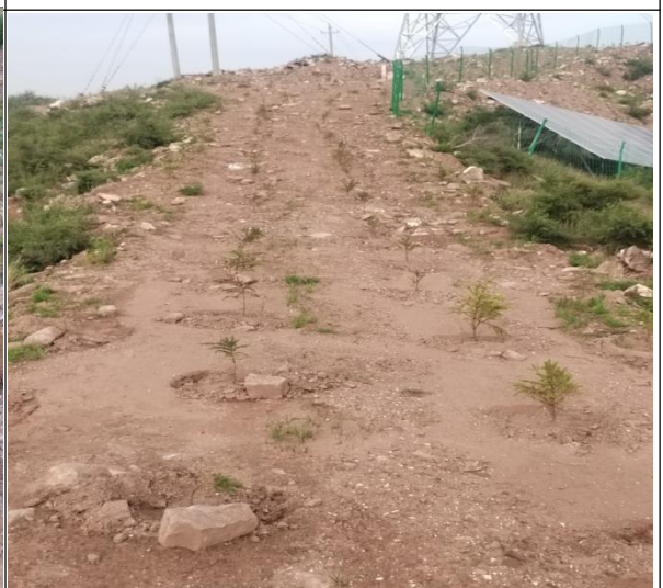
施工便道植被恢复（种植油松）
