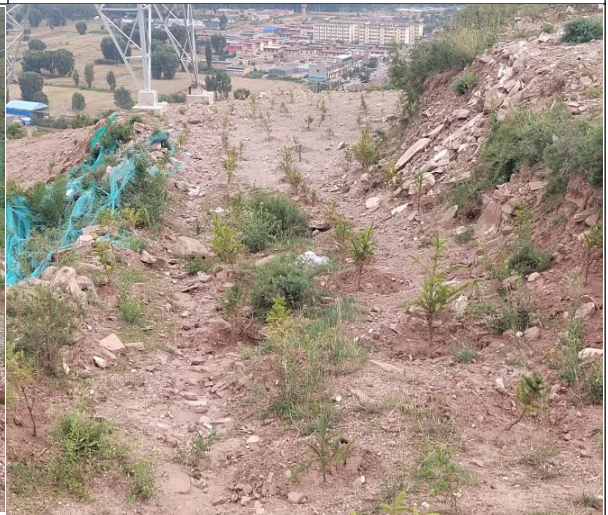
施工便道植被恢复（种植油松）
