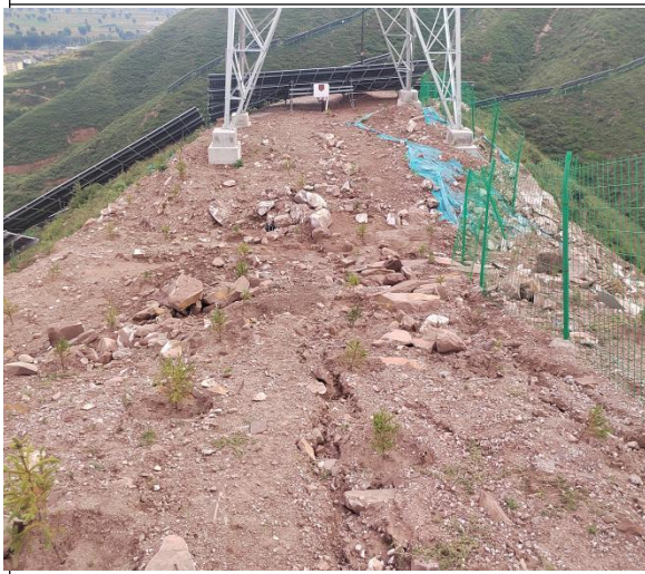
施工便道植被恢复（种植油松）
