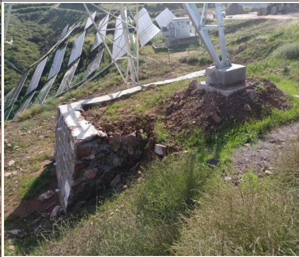
1#塔基土地回填及植被恢复
