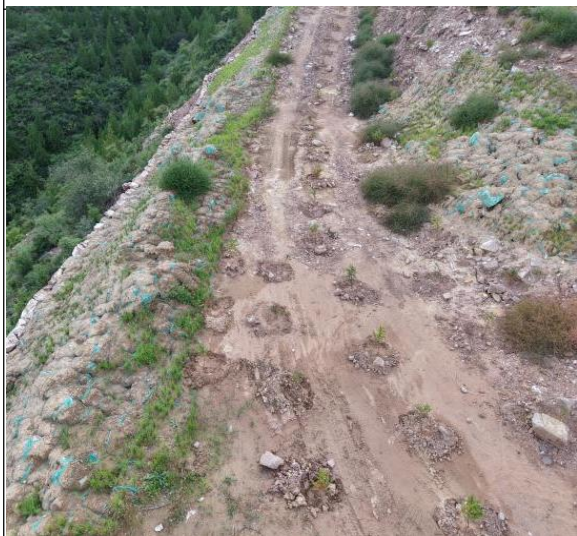
施工便道植被恢复（种植油松）
