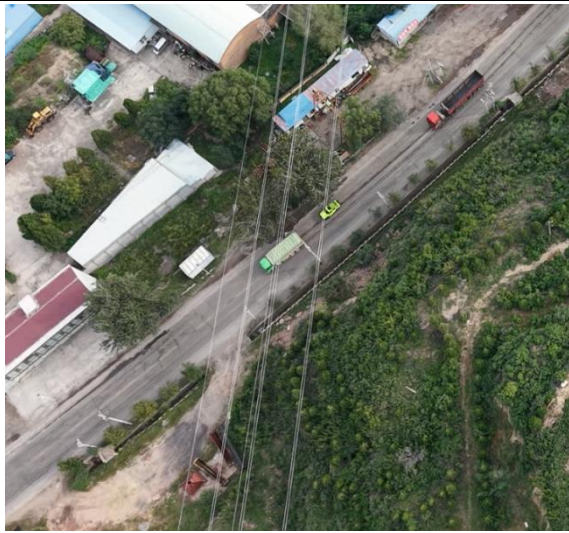
6#塔基-7#塔基跨越 307 国道
