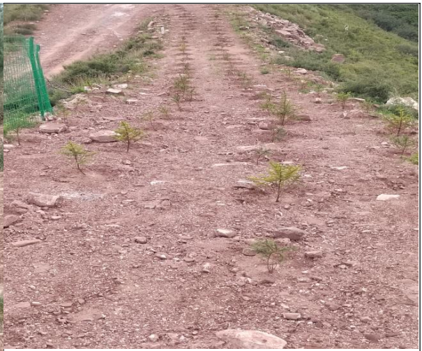
施工便道植被恢复（种植油松）
