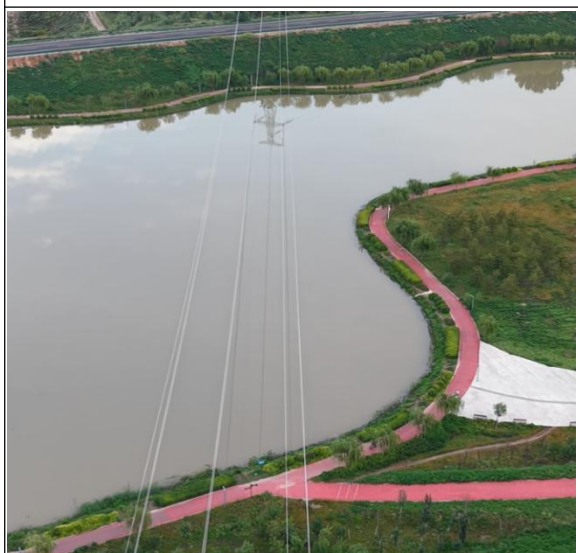
10#塔基-11#塔基跨越文峪河
