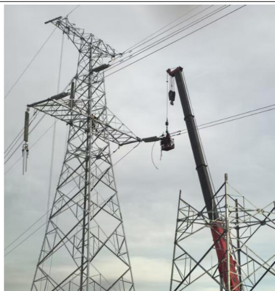
拆除 031 和 032 号塔基，新建 G1 和 G2 塔基
